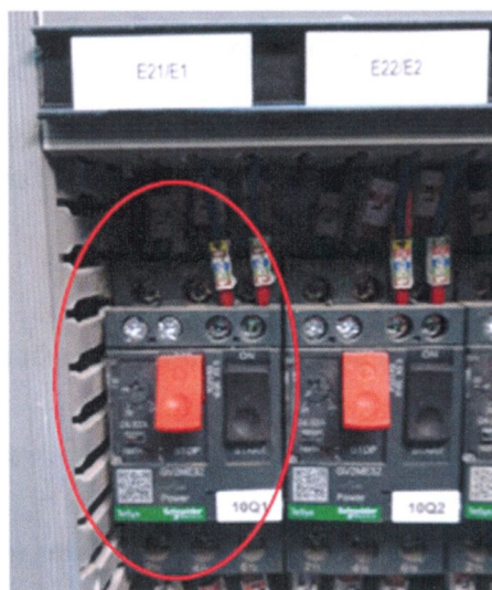
Disjoncteur/Sectionneur protection élévateur E21
